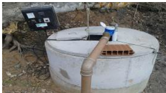
Figura 04 – Instalação de poço profundo
