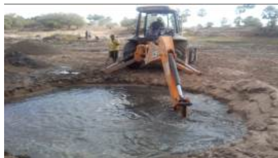
Figura 06 – Escavação do poço de Jacó
