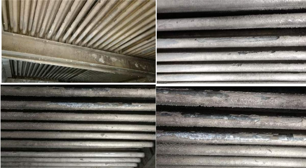
Fotos 10 a 13 – Situação dos tubos do condensador evaporativo 5A testemunha após 200 dias de tratamento Solavite Hydro (Nota: as partes sem incrustações nos tubos do CE 5A são decorrentes de remoção mecânica realizada pelo operador da Cerpa.)
