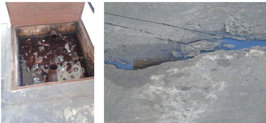
Figura 2: Duas imagens referentes aos Postos 1 e 4, respectivamente. Na primeira, se observa uma caixa separadora de água e óleo com presença de resíduos sólidos em suspensão, o que reduz sua eficiência. Na segunda, rachaduras no piso da pista de abastecimento favorecem a infiltração de contaminantes.
