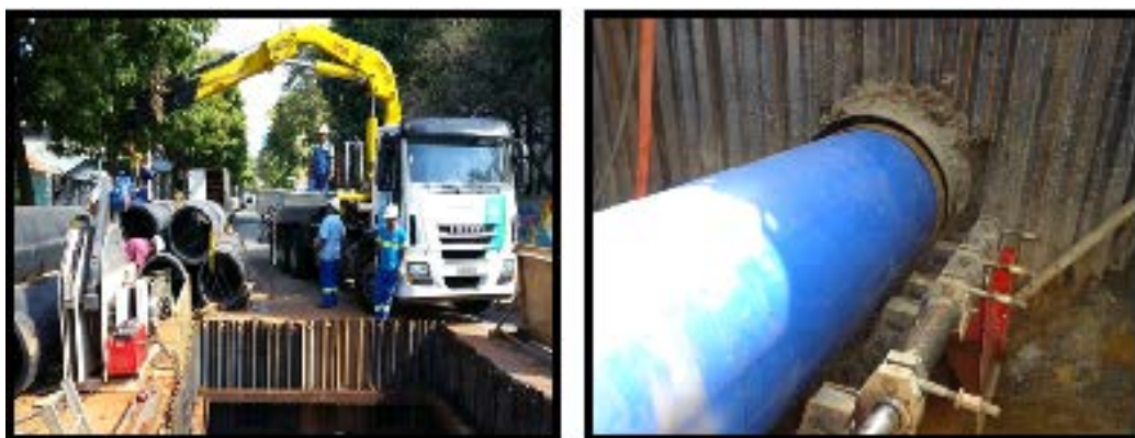
Figura 10: inserção da tubulação dentro da adutora.
