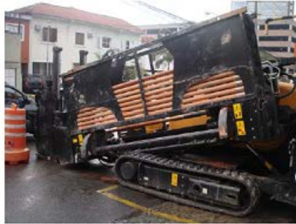
Figura 5: furo piloto, máquina perfuratriz com hastes metálicas e tubulação de PE. (Fonte: Sabesp/MCEA)
