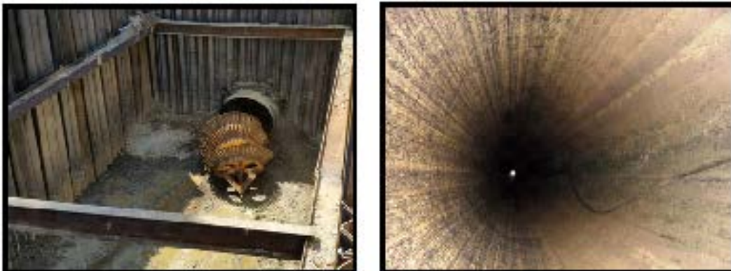
Figura 9: limpeza da tubulação por meio de raspagem da rede.
