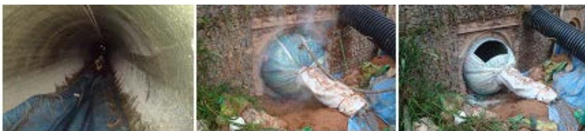
Figura 14: etapas do método CIPP: inserção da manta, injeção de vapor e término da cura. (Fonte: Diniz M. Barbosa /Re-pipe Sistemas Não Destrutivos)
