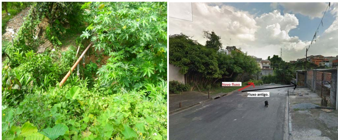
Figura 6: Rede atravessando por cima do fundo de vale para desviar o fluxo com defeito e substituir projeto MND
