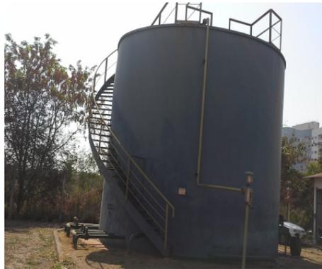
**Figura 3: Reator UASB na ETE de Várzea Grande-MT**
