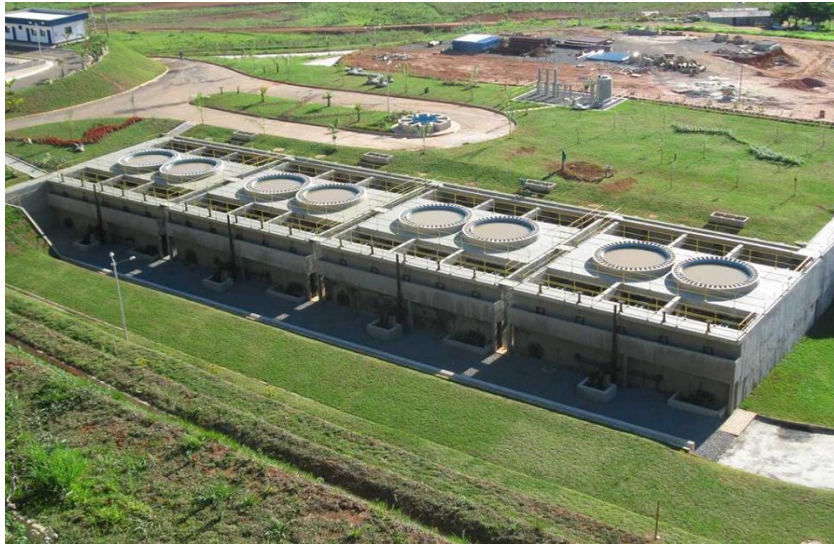
Figura 1. Reatores UASB da Estação de Tratamento de Itajubá. Figure 1. UASB Reactors of the Itajubá Treatment Station. Fonte: PROENCIS - Projeto de Engenharia Civil e Saneamento
