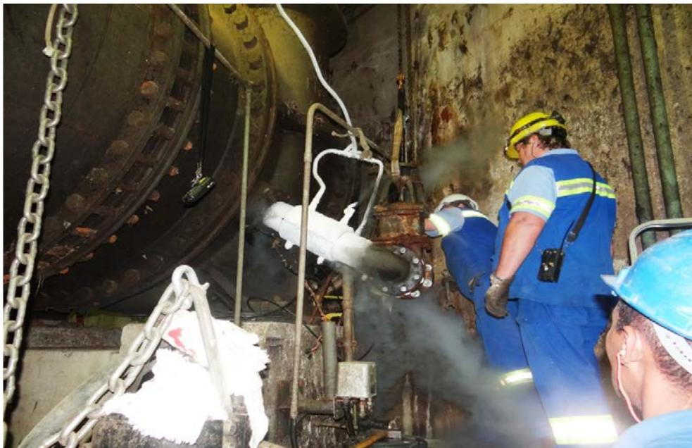
**Foto 3: Após congelamento a montante e a jusante da tubulação DN150 do “by-pass”, início da retirada da válvula com problema de vedação.**
