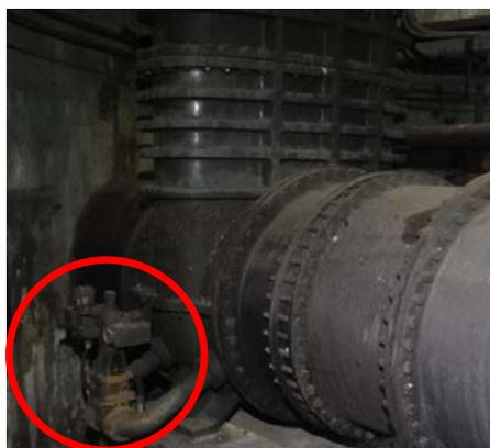
**Foto 1:** Indicação da válvula DN150 do “*by-pass*” onde foi identificada passagem de esgoto
