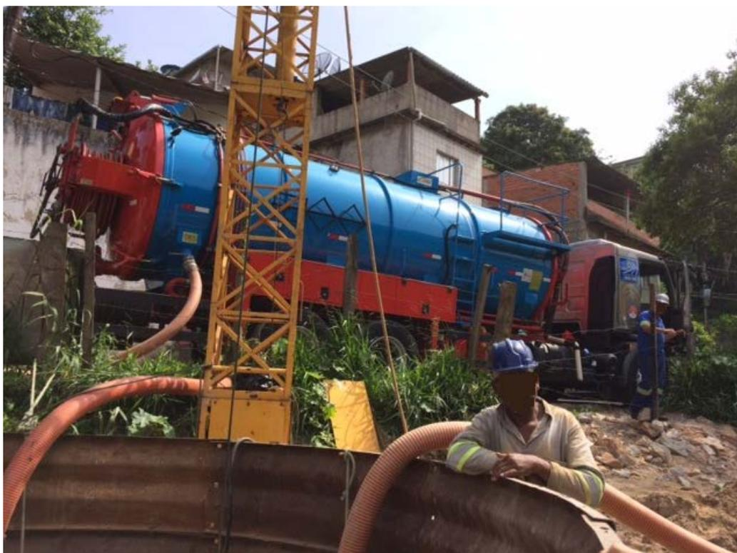
**Figura 4. Poço de serviço para execução de redes de esgoto, mão de obra e equipamento para sucção da lama. Fonte: Autor.**
