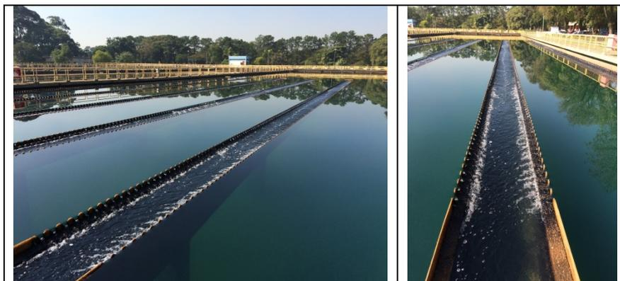
Figura 2: Calhas coletoras dos decantadores da ETA RJCS.
