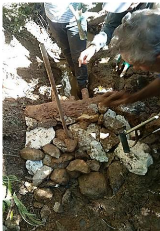
Figura 10: Encaixe do tubo de desinfecção
