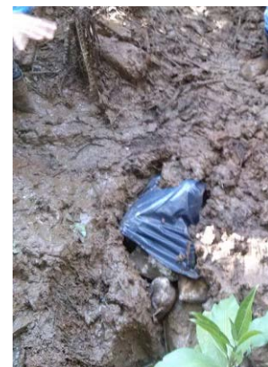
Figura 6: Cobertura com solo
