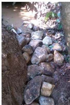
Figura 4: Colocação de rochas
