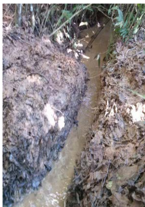
Figura 3: Escavação de valas
