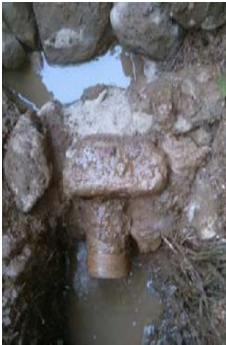
Figura 7: Tubo de limpeza
