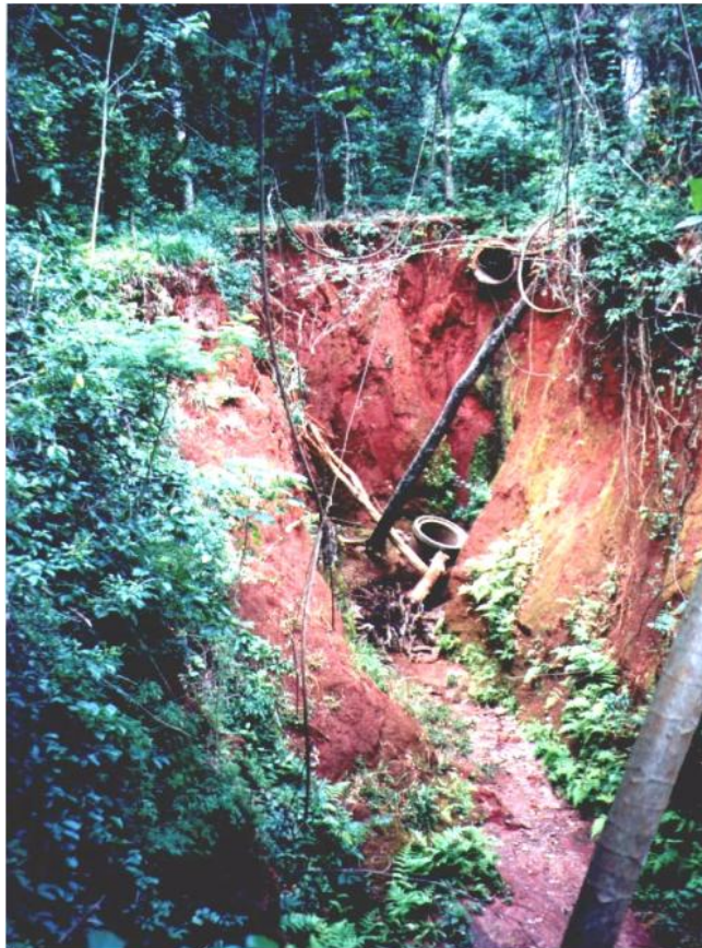
Figura 2: Cabeceira da ravina da Av. Paraná, evidenciando-se, ao fundo, o coletor de águas pluviais
