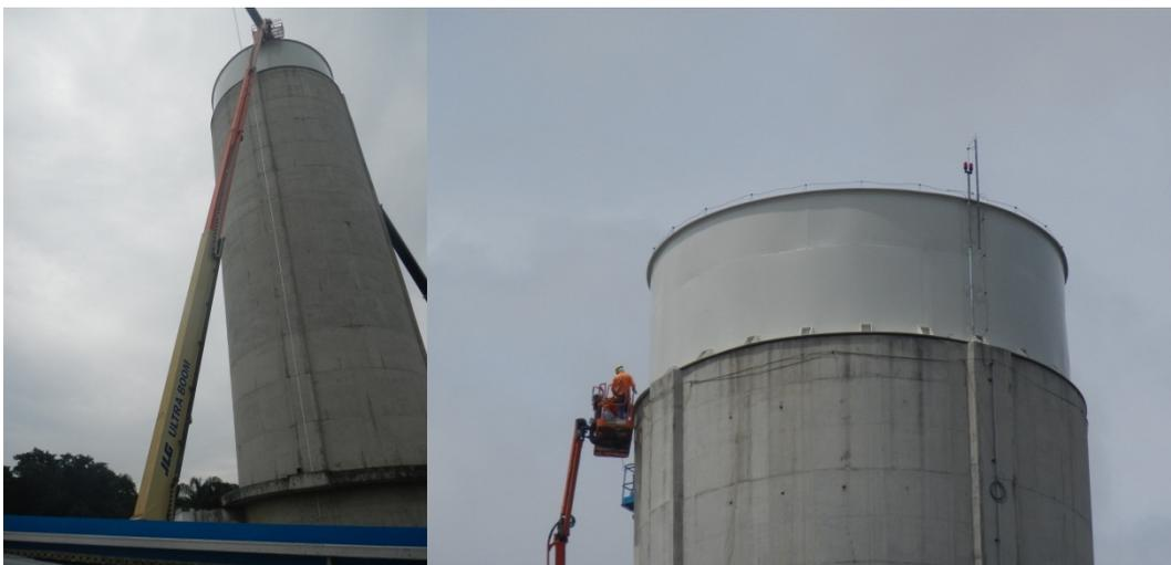
**Figura 8 - Instalação do complemento metálico da chaminé de equilíbrio.**
