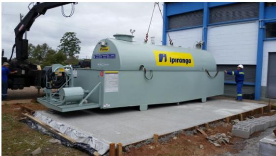
**Figura 6 - Instalação do tanque estacionário (15m3)**
