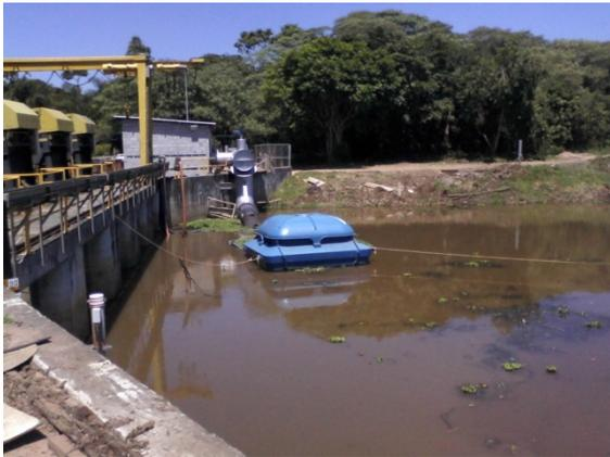
**Figura 4 - Instalação do conjunto motobomba flutuante.**
