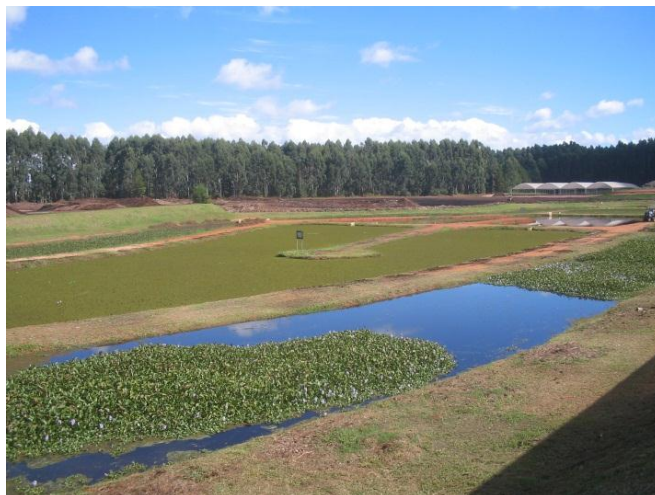
Tratamento de águas em "wetland" com plantas flutuantes
