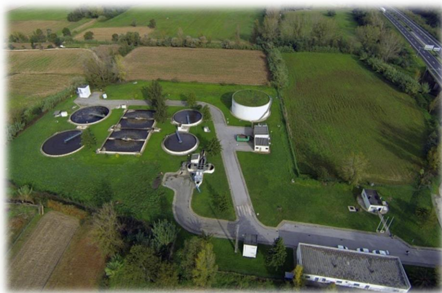
Figura 3.1 - Vista da ETAR da Ribeira de Frades.
