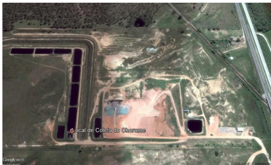
Figura 1. Vista aérea do Aterro Sanitário de Rio Grande
