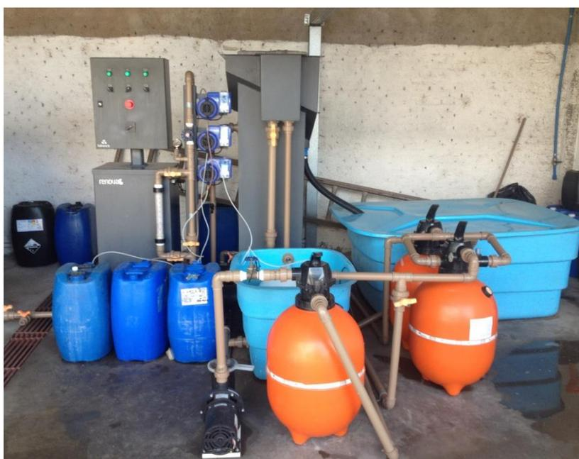
Figura 11. Fotografia do equipamento de floculação-flotação instalado no sistema de reciclagem de água na lavagem de veículos.
