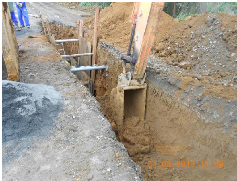
Figura 6 - Execução de escavação
