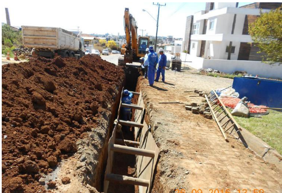
Figura 8 - Escoramento metálico
