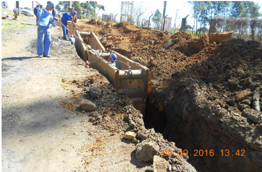
Figura 7 - Escoramento metálico
