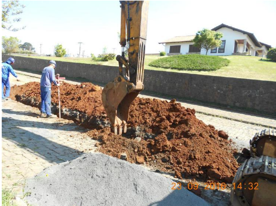
Figura 5 - Execução de escavação
