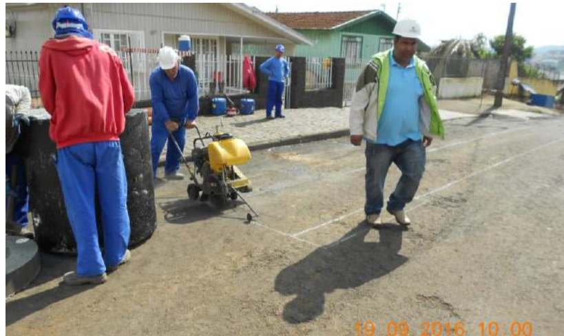
Figura 2 - Execução de remoção asfáltica
