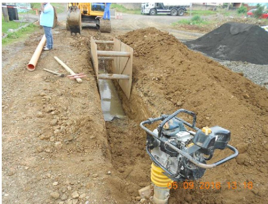
Figura 4 - Registro de rompimento de cano
