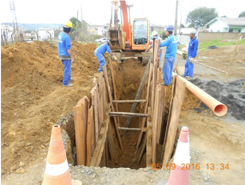
Figura 9 - Escoramento tipo estaca-prancha
