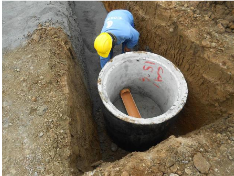
Figura 13 - Assentamento de PV
