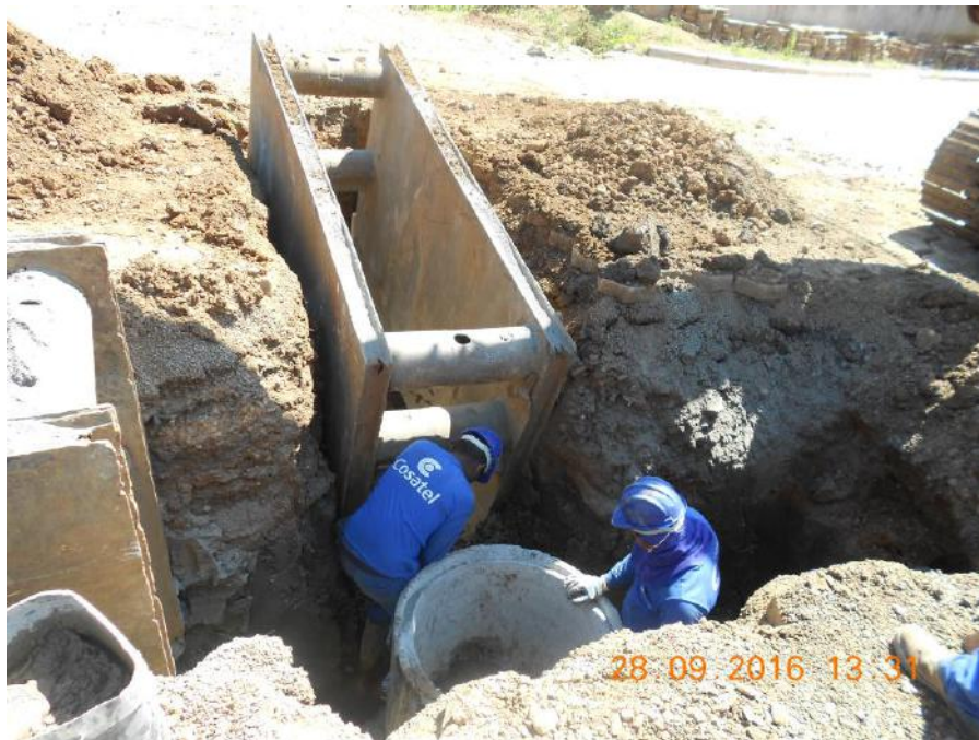
Figura 14 - Escoramento metálico e assentamento de PV
