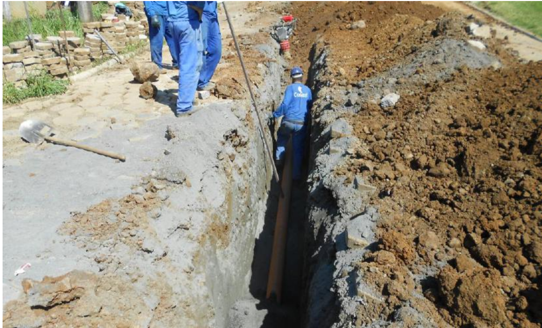
Figura 11 - Tubo assentado sobre lastro de pó de brita
