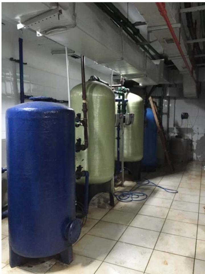
Figura 8 - Equipamentos de filtração e limpeza
