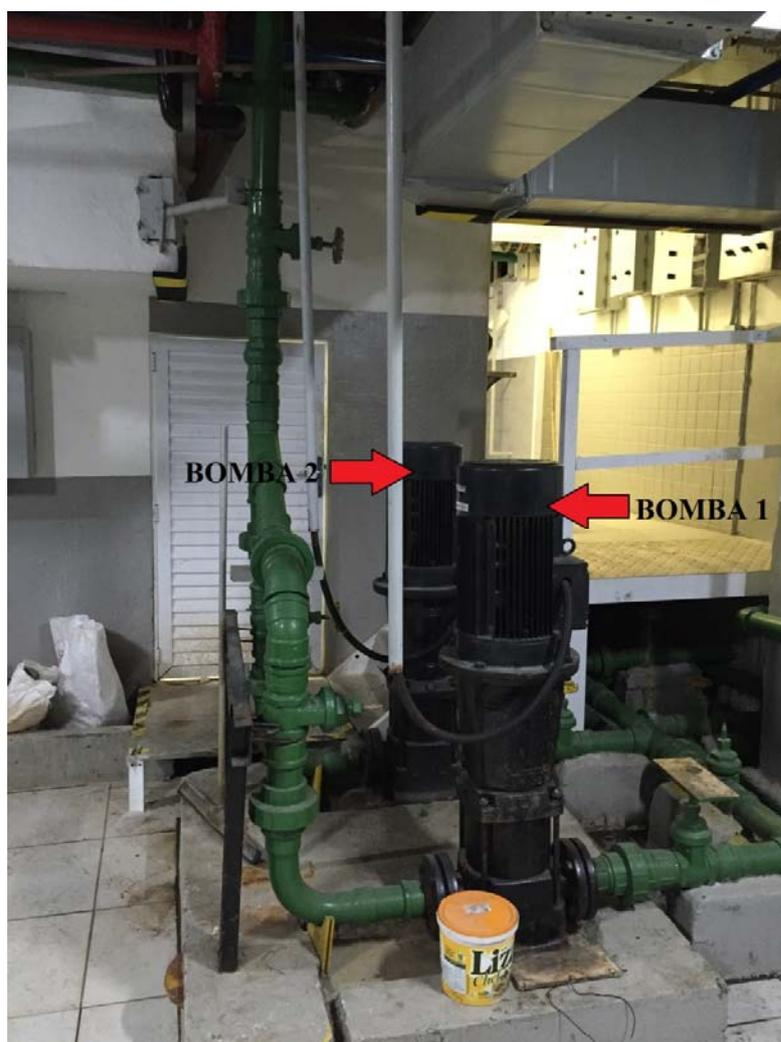
Figura 11 - Sistema de recalque 1 (água da CEDAE)
