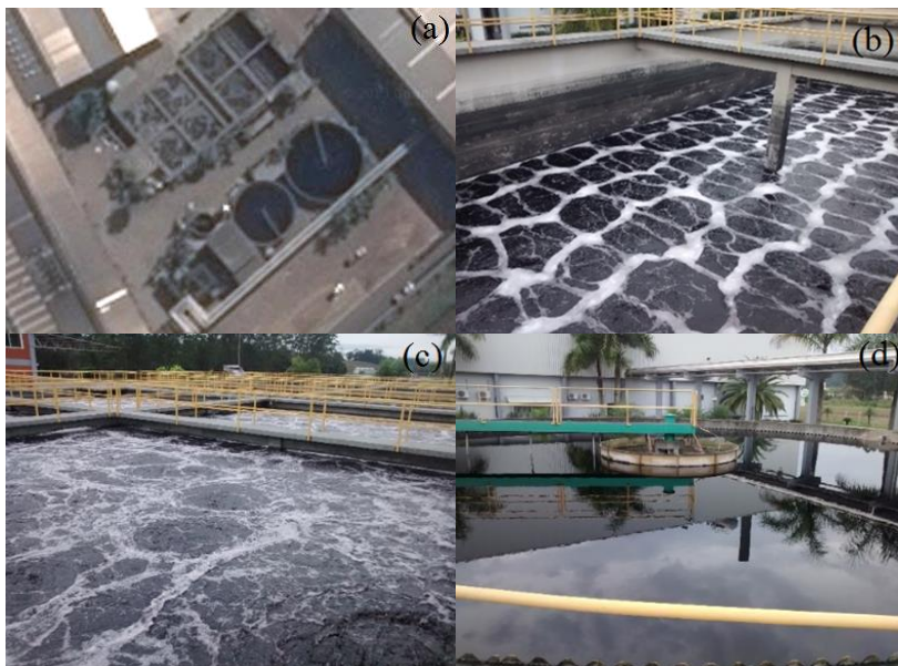
Figura 9. Estação de tratamento de efluentes da tinturaria: (a) vista de cima da estação completa; (b) tanque de equalização; (c) tanque de aeração; (d) decantador.
