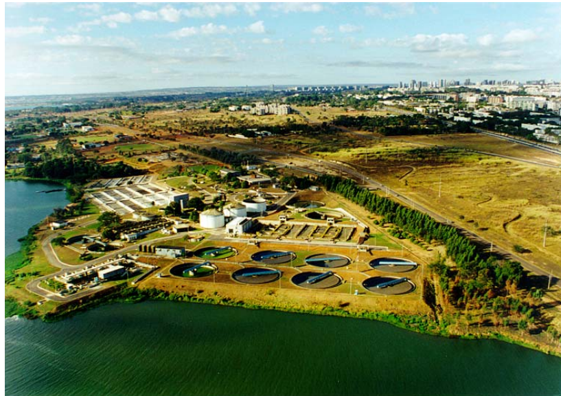
Figura 1: Vista superior da Estação de Tratamento de Esgoto de Brasília - Norte (ETEB Norte). Foto cedida pela CAESB.
