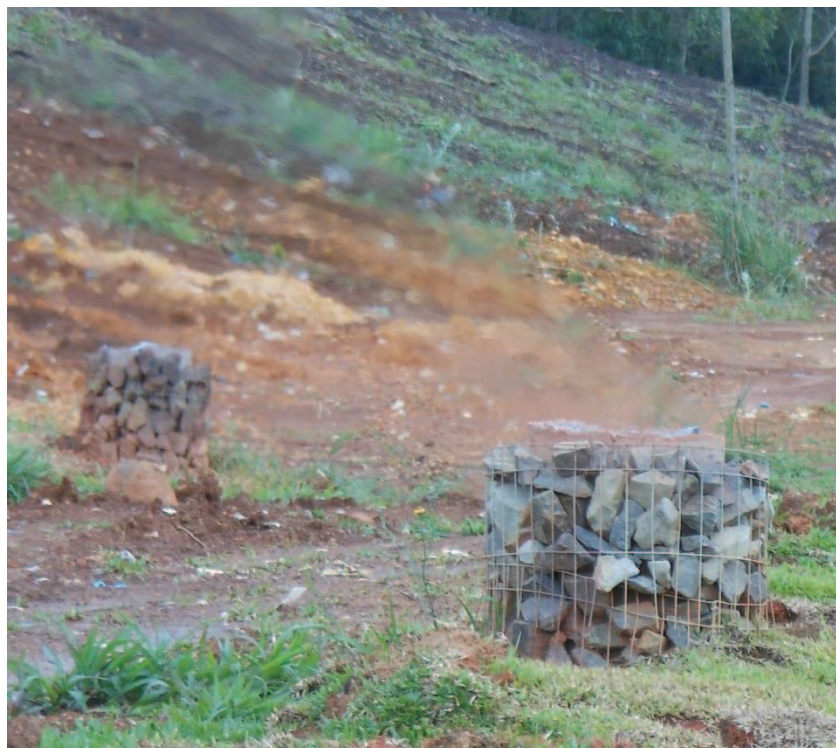
Figura 8 - Dreno de gás metano queimando de forma contínua.
