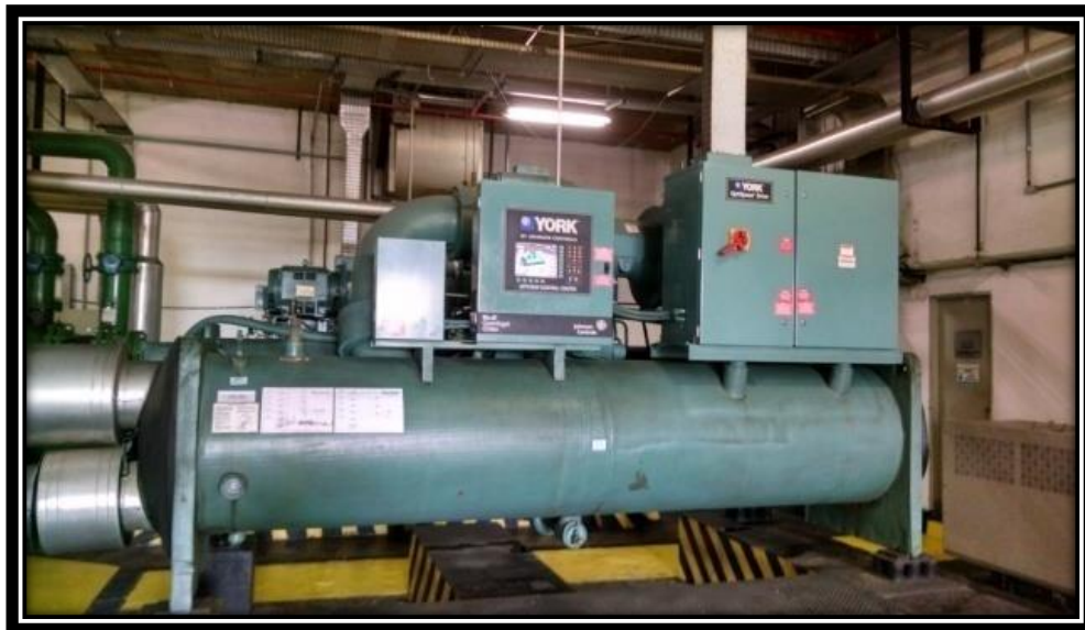
Figura 4.3: UR03 – Chiller centrífugo York de 400 TR.
