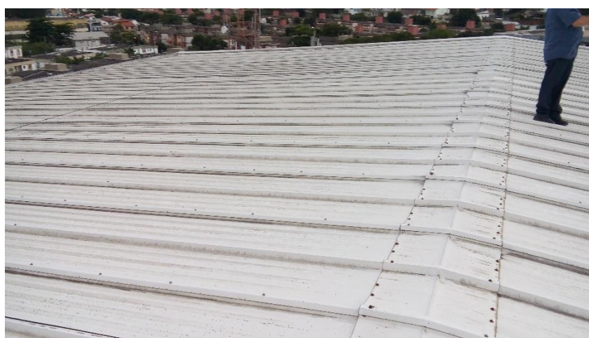
Figura 4.6: Telhado do cinema.
