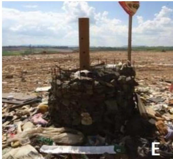
E) Dreno em construção envolvido na camada de brita
