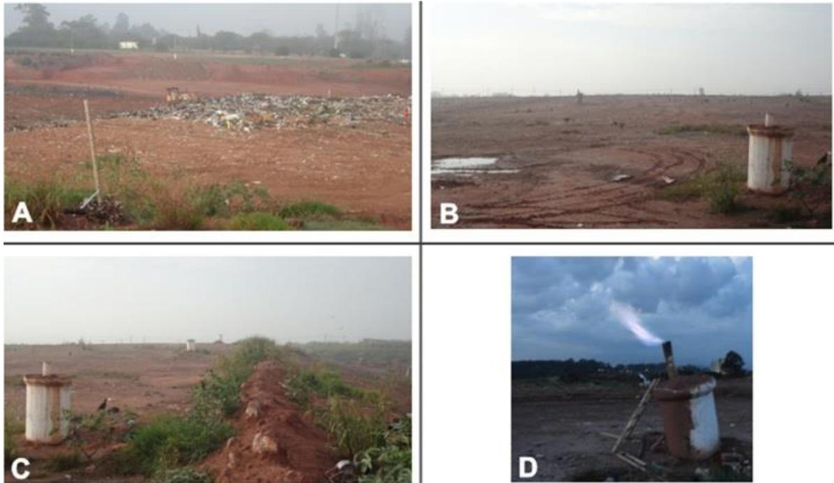
**Figura 3:** A) Disposição de resíduos em célula ativa. B) Vista parcial de célula estudada. C) Orientação de drenos D) Dreno com queima de biogás
