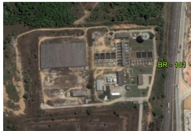
Figura 1 – Estação de Tratamento Gramame, Conde-PB.
