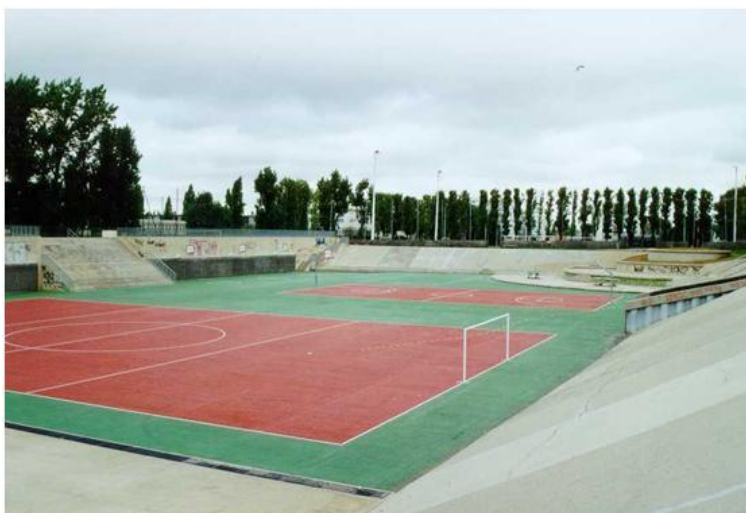
Figura 7- Bacia de detenção na bacia Maurice Audin – França
