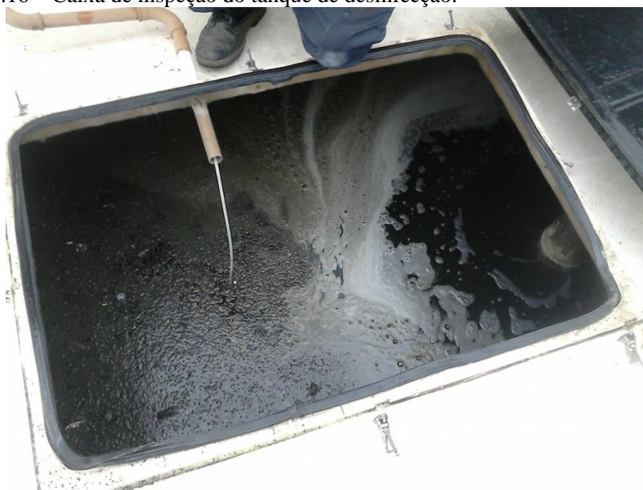
Figura 4.16 – Caixa de inspeção do tanque de desinfecção.
