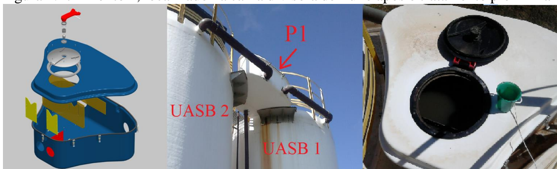
Figura 4.17 – Ponto 1, localizado na caixa divisora de fluxo após o tratamento preliminar.
