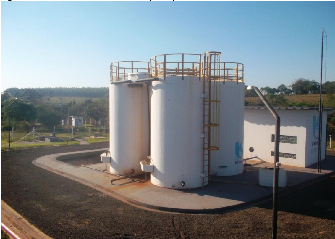
Figura 4.2 - Sistema de tratamento composto por reator UASB e BAS.
