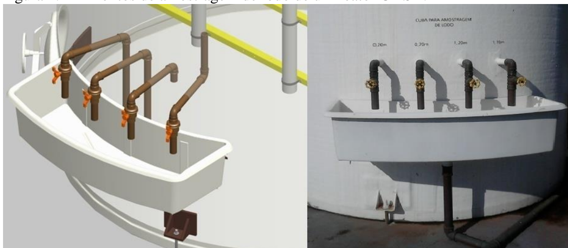
Figura 4.21 – Pontos de amostragem de lodo de um reator UASB.
