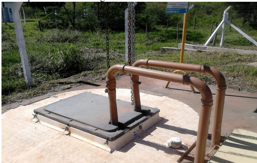
Figura 4.7 - Estação elevatória de esgoto.
