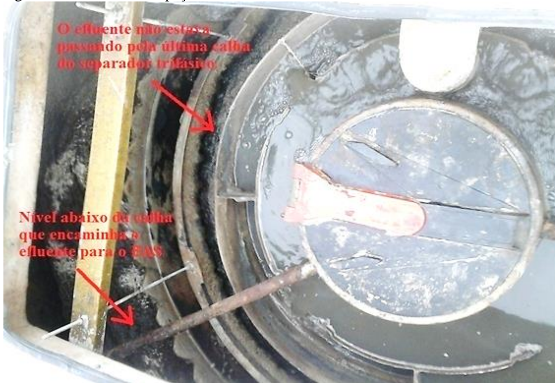
Figura 5.22 - Caixa de inspeção do reator UASB 1.
