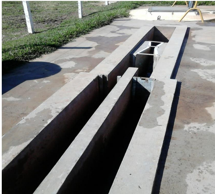
Figura 4.6 - Caixa de areia e calha Parshall.
