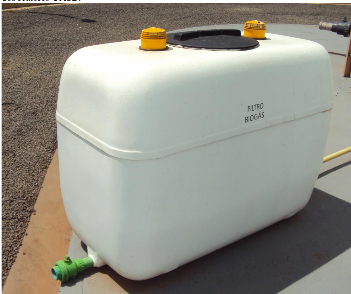
Figura 4.12 - Filtro de biogás para tratamento dos gases segregados no separador trifásico dos reatores UASB.
