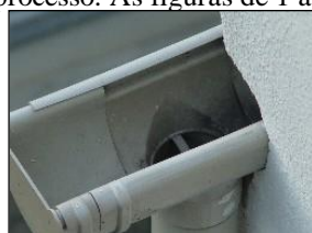
Figura 2 – Calha
