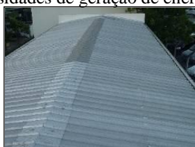
Figura 1 – Telhado de coleta da água de chuva
