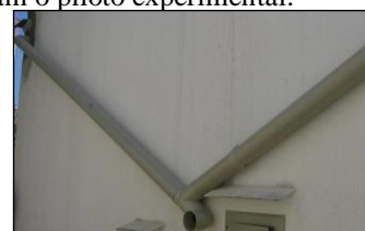
Figura 3 – Condutores da água da chuva
