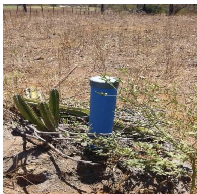
Figura 2 – Detalhe do poço artesiano estudado.
