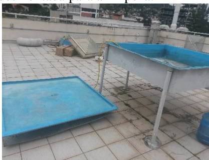
Figura 9 – Reforma e limpeza da pirâmide 1. Fonte: Do autor.
