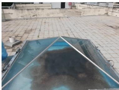
Figura 10 Efluente a ser tratado na bandeja. Fonte: Do autor.
