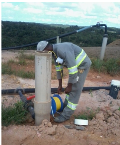
Figura 5-16 – Inserção do medidor de nível no dreno
