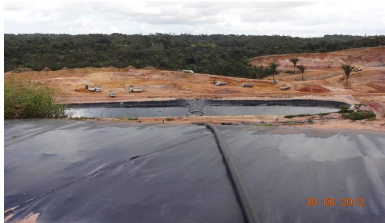
Figura 4-9 – Registro fotográfico das bacias gêmeas de contenção de chorume
