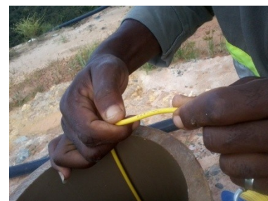
Figura 5-18– Verificação do nível de chorume no dreno
