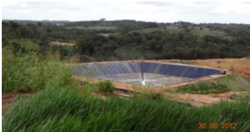
Figura 4-10 – Registro fotográfico da bacia envelopada de contenção de chorume
