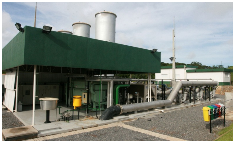
Figura 4-4 – área de compressores e filtros.
