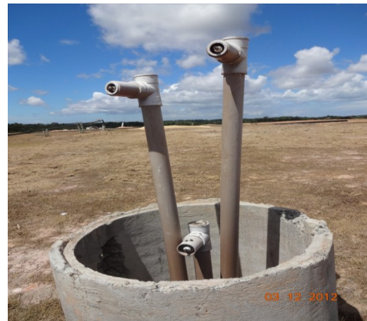
Figura 3-2 - Registro fotográfico piezômetro câmara dupla instalado no ASMC.
