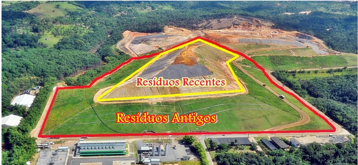
Figura 5-2 – Registro fotográfico macrocélula 1 – destaque para áreas de disposição do resíduo sólido recente e resíduo sólido antigo.
