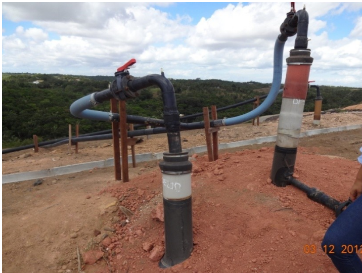
Figura 4-5 – Sistema de recuperação de biogás
