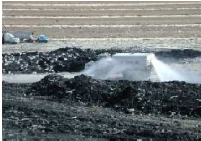
Figura 3-16 – Pulverização do chorume via caminhão-tanque.
