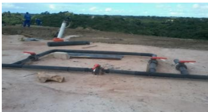
Figura 5-20 – Local da instalação inicial do hidrômetro.
