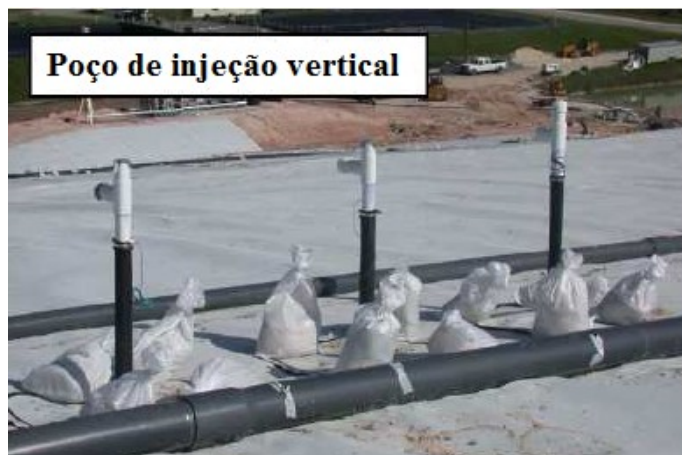
Figura 3-17 – Poços de injeção de chorume.
