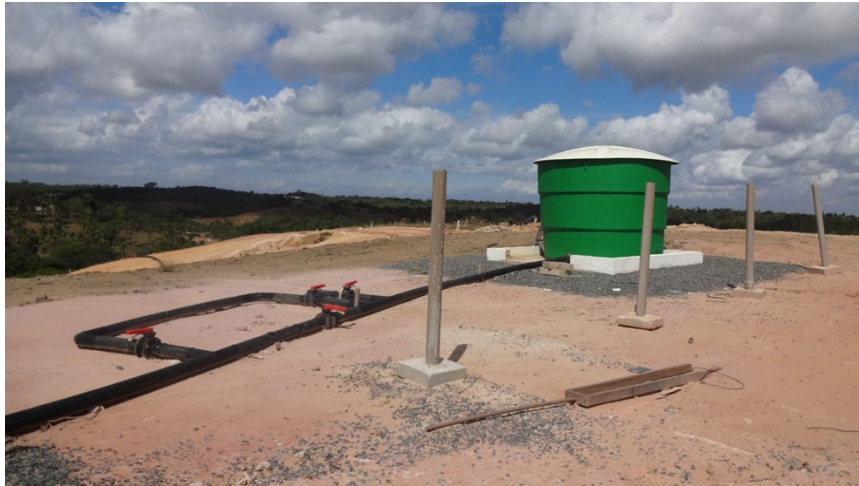
Figura 5-9 – Tanque de recirculação de chorume.
