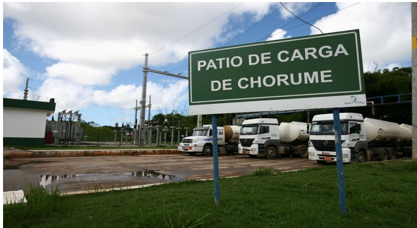
Figura 4-11 – Registro fotográfico do pátio de carga de chorume
