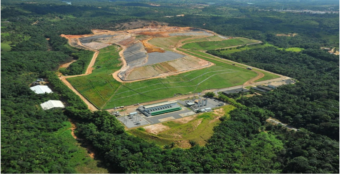
Figura 4-1 – Vista aérea do ASMC.
