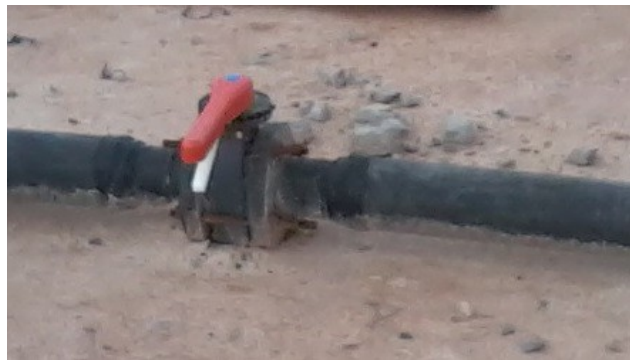
Figura 5-10 – Válvula de retenção e controle da taxa de injeção de chorume.
