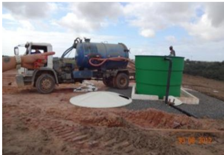
Figura 5-19 – Procedimento de limpeza do tanque de chorume
