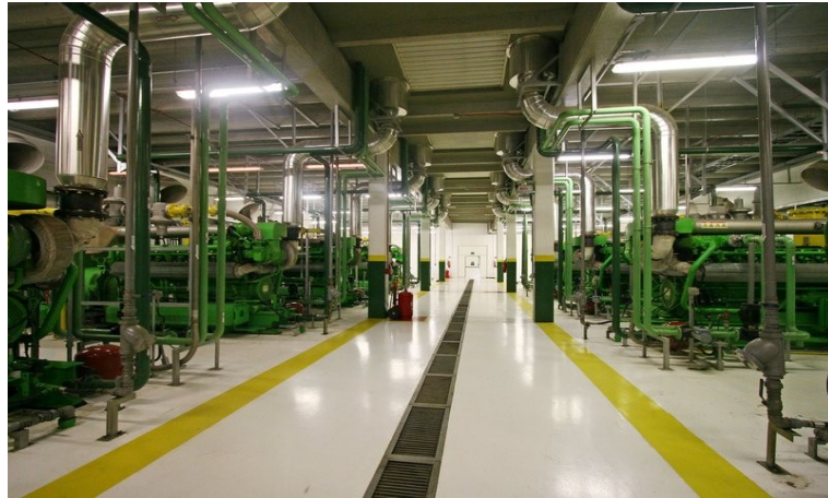
Figura 4-3 – Motogeradores de 1038 KW.
