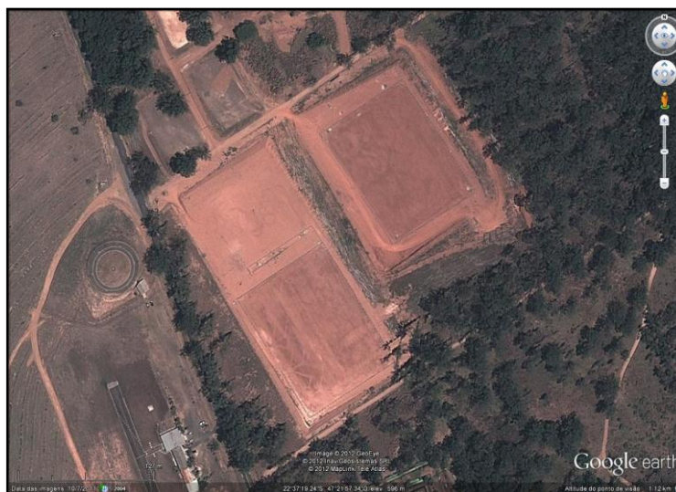
Figura 2. Aterro Sanitário Municipal de Limeira.
