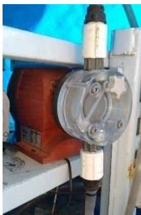
Figura 4.16 – Bomba de recirculação de licor misto no sistema N/D
