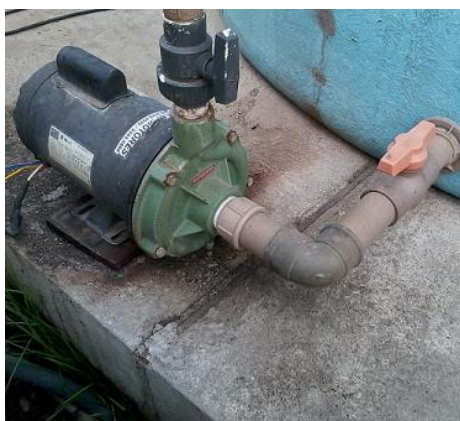
Figura 4.6 – Bombas de homogeneização de esgoto
