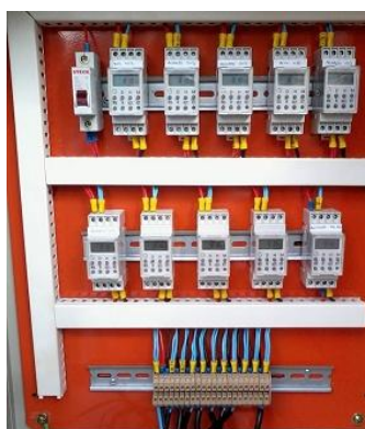
Figura 4.4 – Painel elétrico com temporizadores programados
