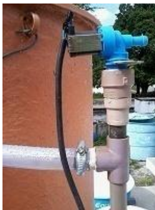
Figura 4.13 – Válvula para entrada de ar na tubulação de descarte
