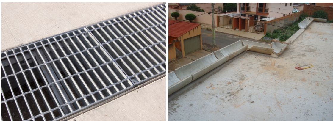
Figuras 3 e 4 – Ralo e manilhas para drenagem da água em lajes. Fonte: http://omelhordemorar.blogspot.com.br/2011/04/como-faco-para-dimensionar-o-escoamento.html e http://oterceirososho.blogspot.com.br/2012/01/beiral-de-calha-embutida.html .
