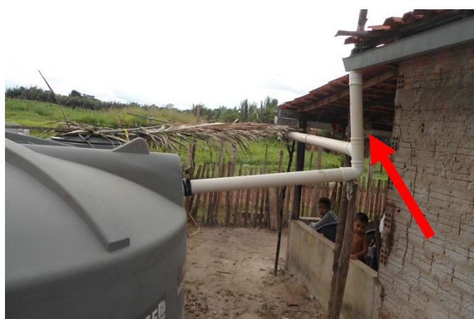
Figura 2 – Sistema de captação de água – Programa Água para todos no Povoado de Cinzento, município de Pirapemas, Maranhão. Fonte: acervo dos autores.
