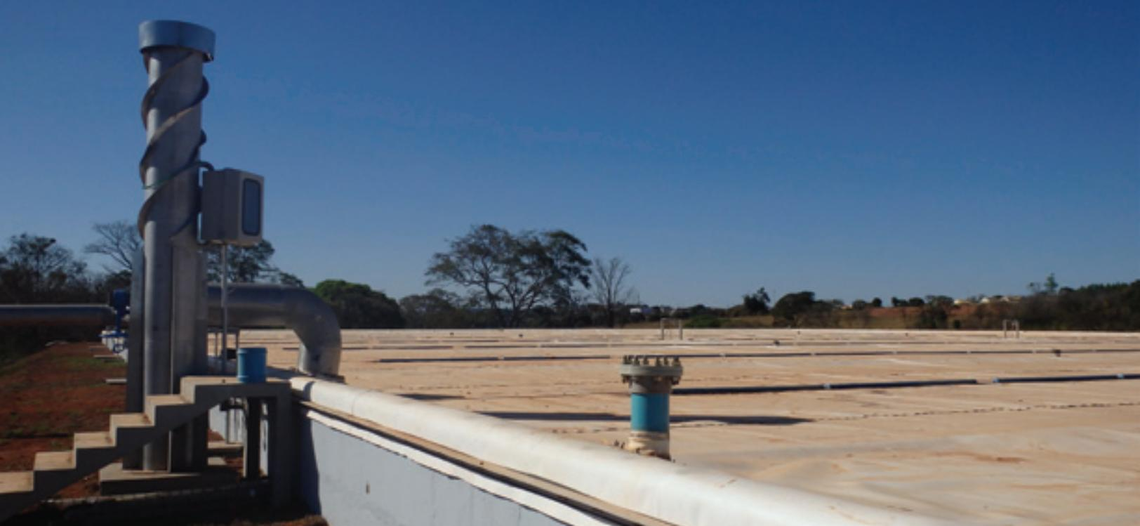
O efluente da planta produtiva, que inclui uma linha de sorro difícil de tratar, vai para um tanque de equalização, de onde é bombeado para o reator ADI-BVF®. O off-gas gerado no tanque de equalização é enviado para um biofiltro para controle de odores. O efluente tratado no reator ADI-BVF® segue para o tratamento aeróbio reestruturado para polimento final, gerando a qualidade necessária para o descarte do efluente final tratado.
