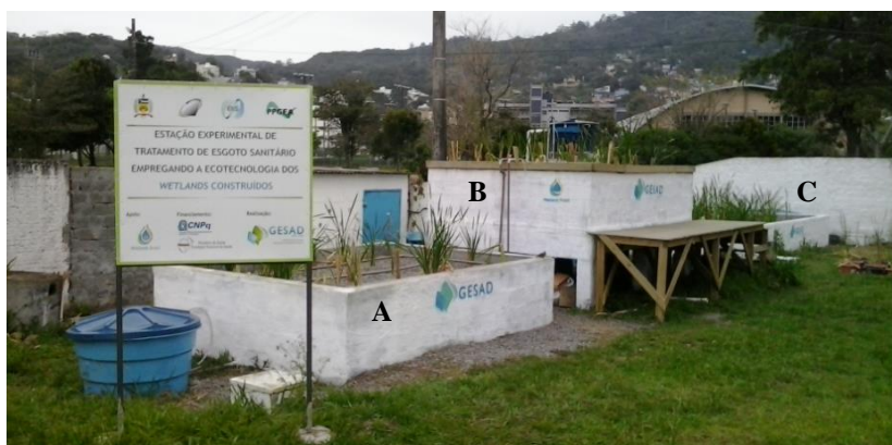
Figura 4 - Estação Experimental de Tratamento de Esgoto Sanitário Empregando a Ecotecnologia dos Wetlands Construídos, onde A – WCVD-FS, B – WCVD e C – WCH.
