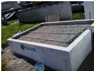
Figura 13 - Tubulação de distribuição antes do plantio das macrófitas.
