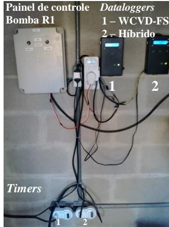
Figura 12 - Equipamentos de aferição da estação de bombeamento.
