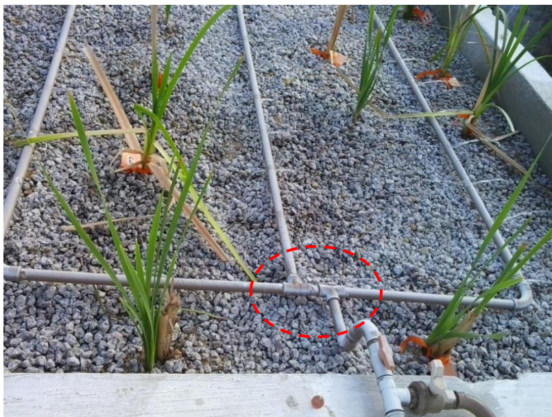
Figura 28 - Tubulação de distribuição.
