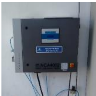
Figura 13 – Analisador de gases instalado e ponto de coleta de gás para análise.
