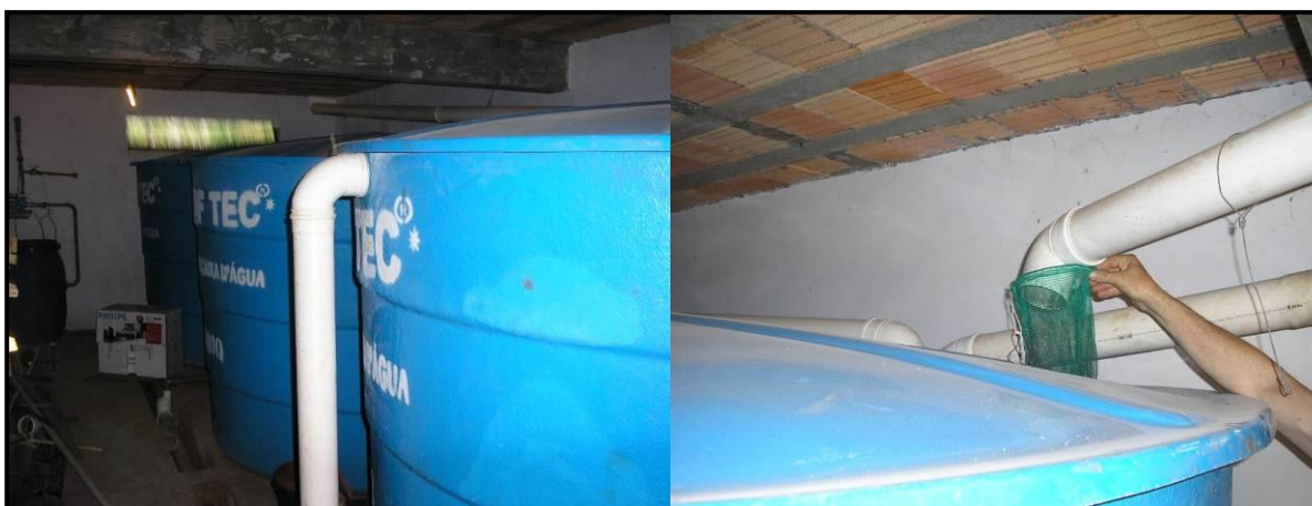
Figura 6: vista dos três reservatório de 5 mil litros, e a rede como filtro para a retirada do material grosseiro (folhas e galhos).
