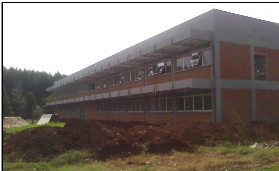
Figura 7: vista do bloco educacional, ainda em obras.
