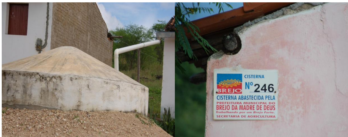
Figura 1: Imagens do sistema de captação de águas pluviais do projeto um milhão de cisternas.
