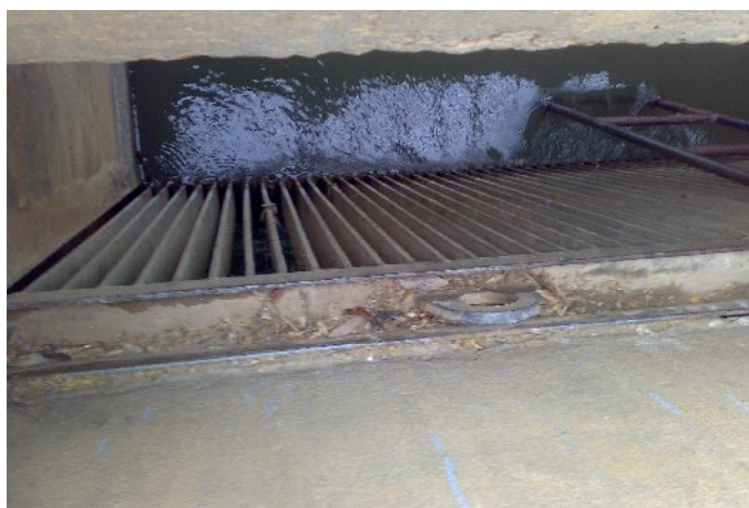
Fig.6 – Zona de gradagem na ETA do Kifangondo
