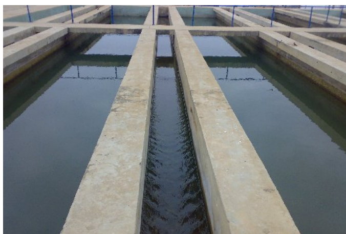
Fig.10 – Zona de filtração da ETA do Kifangondo
