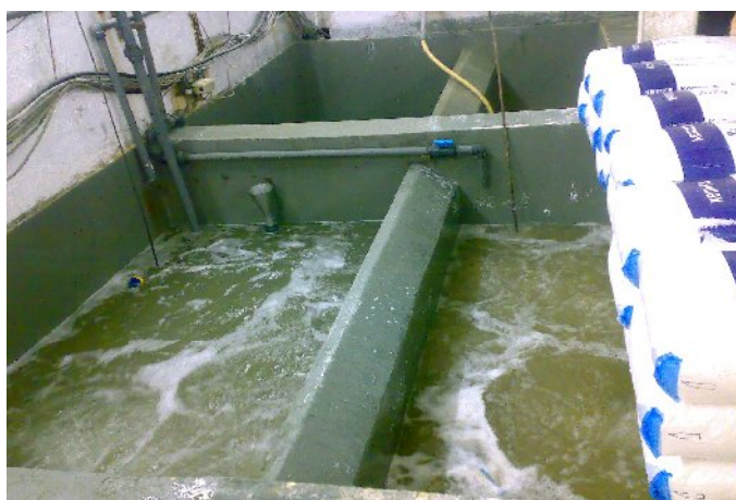
Fig.7 – Zona de mistura de sulfato de alumínio da ETA do Kifangondo
