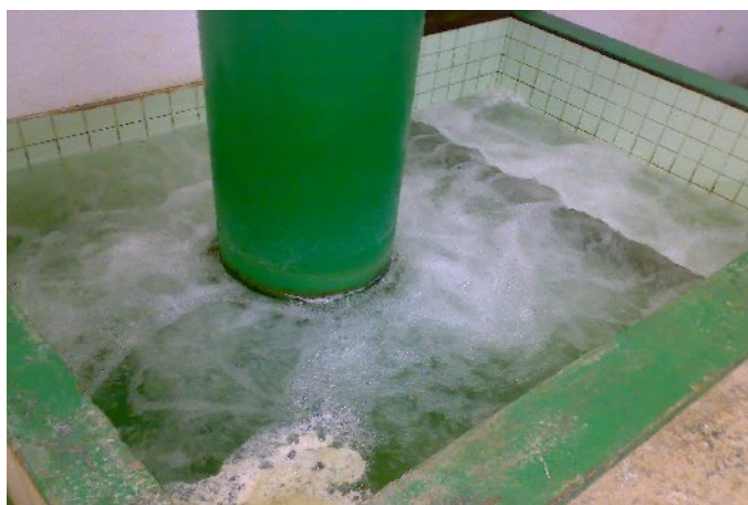
Fig.11 – Zona de cloragem da ETA do Kifangondo
