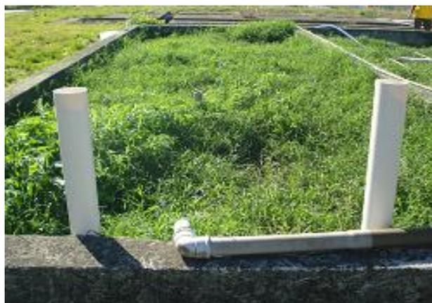
**Figura 4.3:** Tubos de ventilação instalados nos SAC
