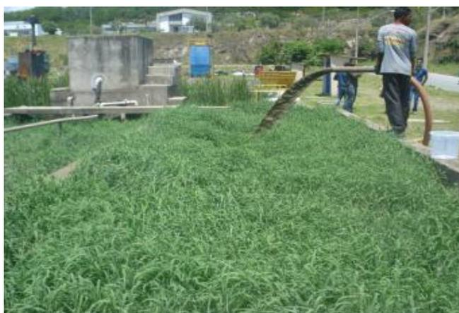
**Figura 4.4:** Aplicação do lodo bruto na UL, destaque para a movimentação da mangueira
