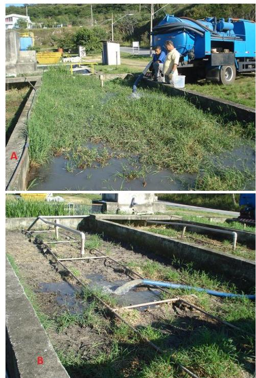
**Figura 4.7:** A) UL recebendo a aplicação de lodo bruto e B) UR1 recebendo o líquido percolado
