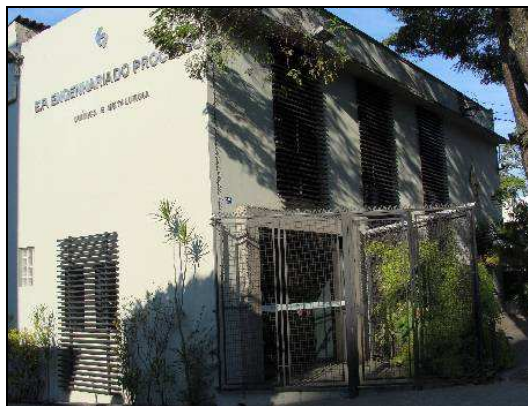
Sede Administrativa – Guarulhos
